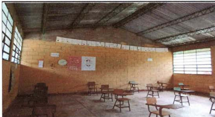
Foto1: Pintura de muros interior
