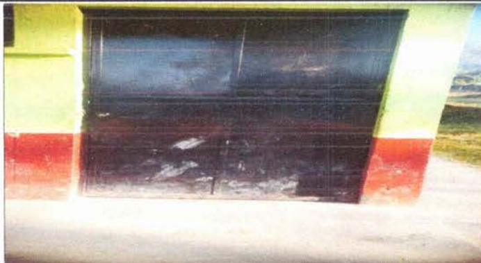
Foto 1: mantenimiento de puertas
