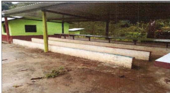
Foto 1: cubierta de blokc del comedor
